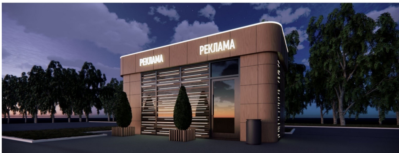
Контурная подсветка парапета и навеса над витражом LED лентой Цвет: -теплый желтый -холодный белый
