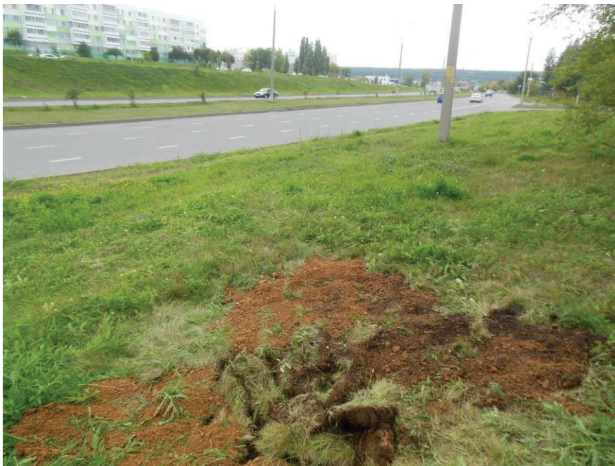
Рис. 21. Шурф № 4. После рекультивации.
